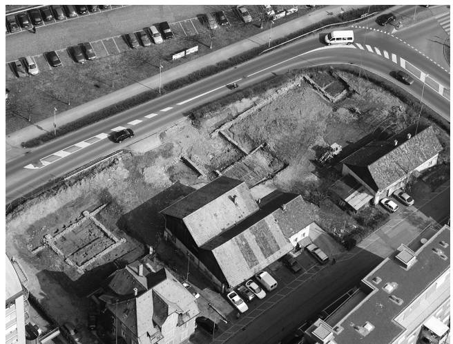
Abb. 20. Neumattstr. 11, 13, 15. Flugaufnahme. Gebäude P, O und F. Rechts unten die Neumattstr. mit den inzwischen abgebrochenen Häusern Neumattstr. 11, 13 und 15. Ansicht aus Westen.
