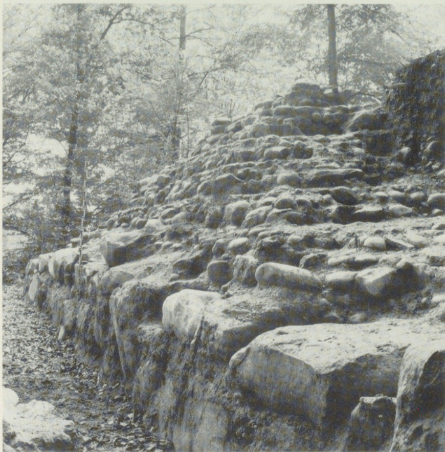
Abb. 25 Der 2,80 m hohe Ostteil der Burgmauer aus Westen. Das Bild zeigt einerseits die fuss- bzw. schuhhohen Schichten bzw. Steinlagen des Mauerkerne und die mächtigen Steinblöcke der Megalithverblendung (links und im Vordergrund).
