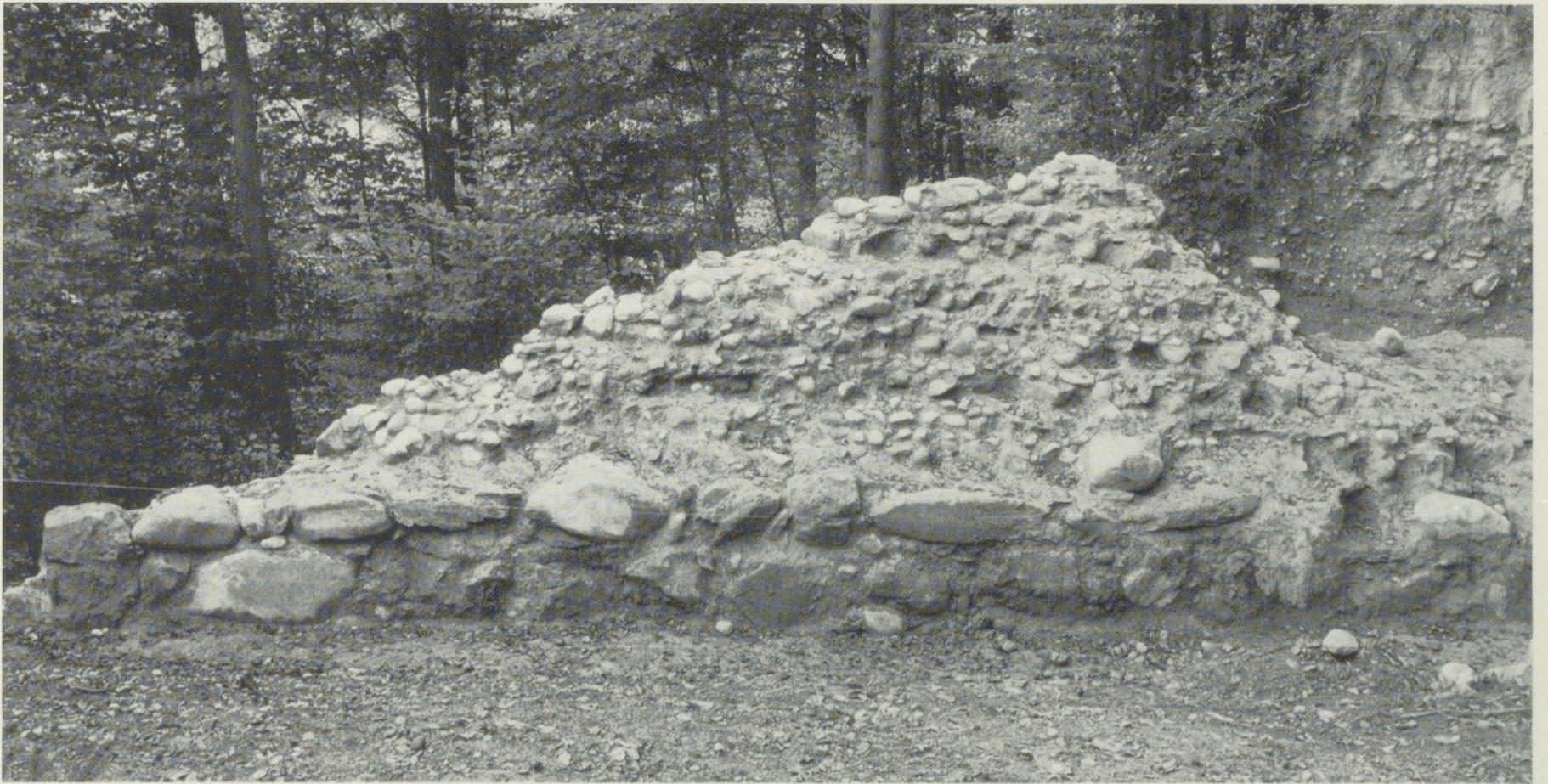
Abb. 24 Grösster Ruinenteil am Ostende der Burgmauer nach der vollständigen Freilegung im Oktober 1980. Aus Norden. – Länge des sichtbaren Abschnittes ca. 10 m, Höhe ca. 2,80 m.
