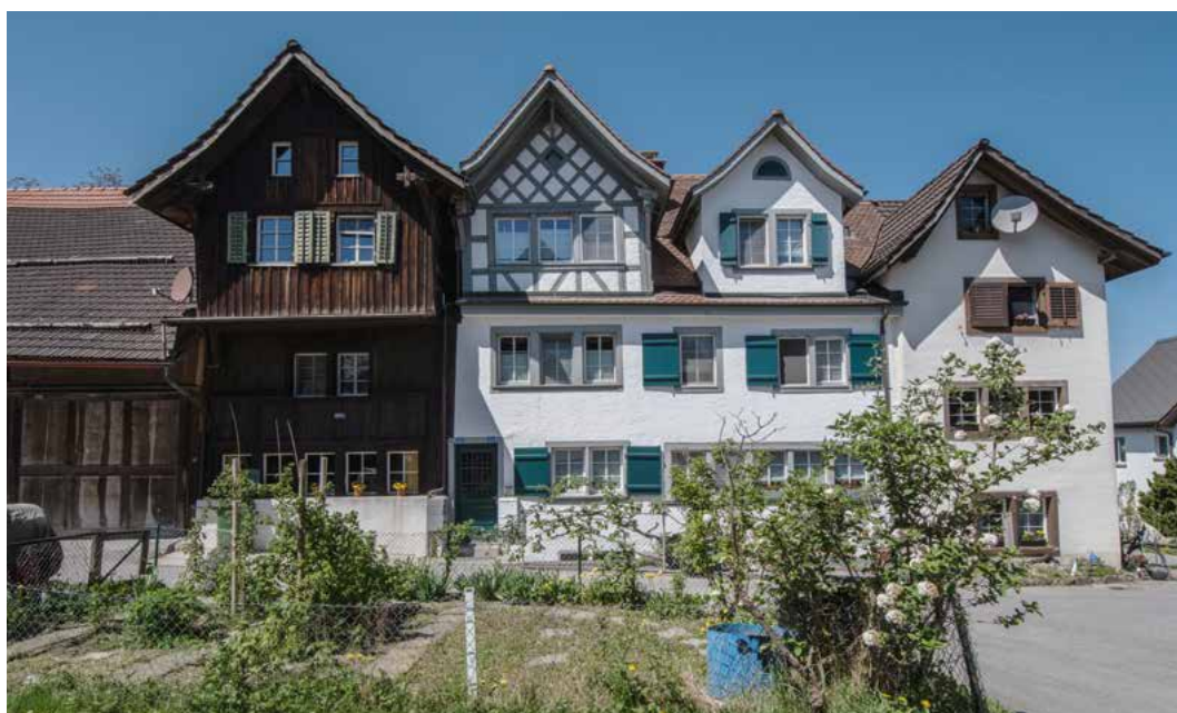
Inmitten von Moorschwand steht dieses alte Flarzhau.
