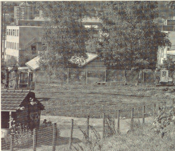
Deponie geräumt. Ende der zonenfremden Nutzung im Areal des Familiengartens beim Unteren Haldenweg
