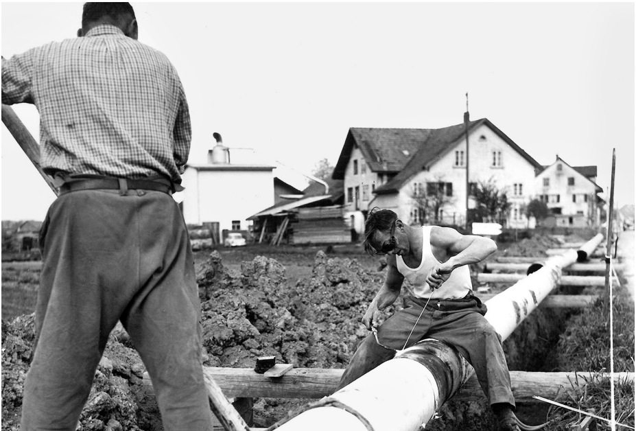
Rohrleitungsbau Ende der 1950er Jahre an der Zürichstrasse. Stahlrohre werden auf der Grube verschweisst und dann mit dem Kran eingehoben.
