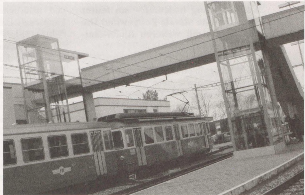
Gerade schiebt sich eine Forchbahn zwischen die beiden Lifttürme. (Fotos: Gisela Goehrke)
