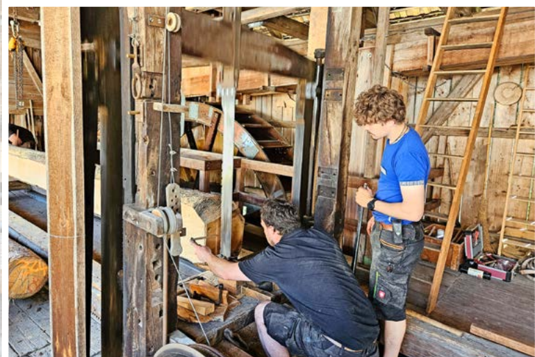
Über den Rücken geschaut: Lukas Bindschädler misst genau, wie breit der Balken gesägt werden muss. Nick Berger hilft beim Einpassen des Stamms. Hier muss ganz genau gearbeitet werden.
