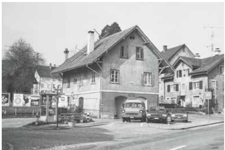
Telefonkabine bei der Bushaltestelle an der Bergwerkstrasse 1, 1987.
