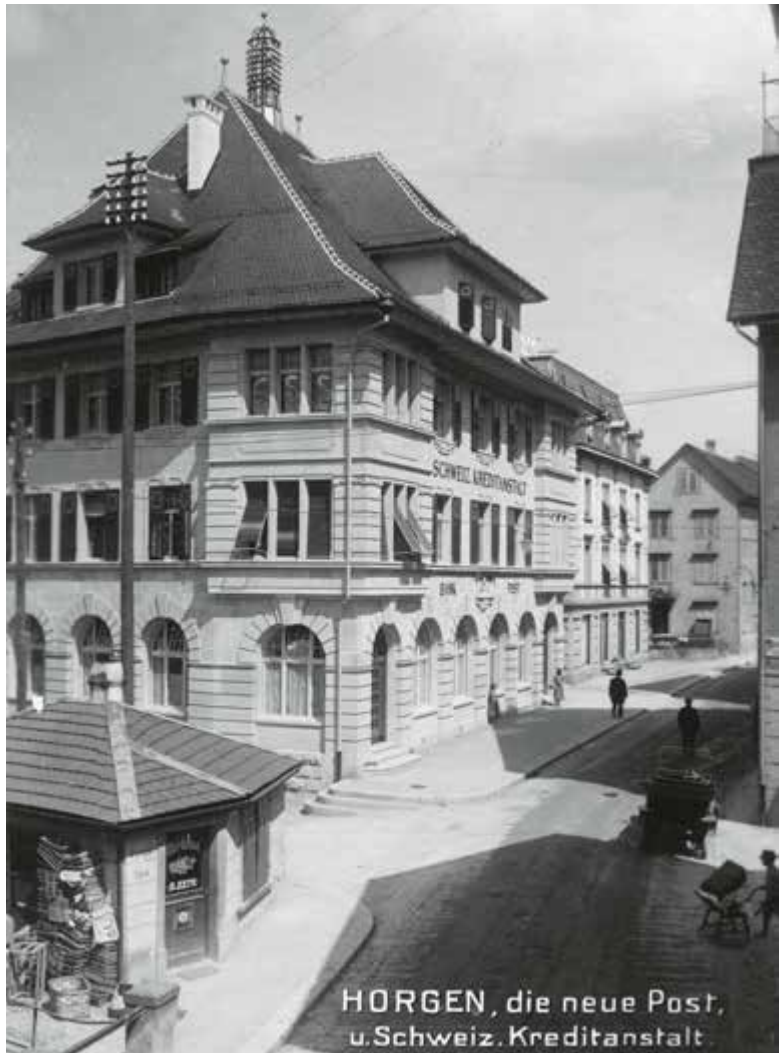
Die 1913 bezogene «neue» Post an der Seestrasse 161, um 1914/15. Auf dem Dach das Tragwerk für die Telefonleitungen zu den Abonnenten.
