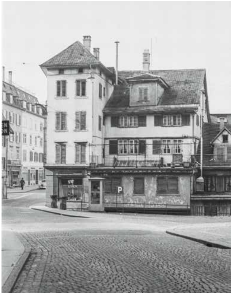
Telefonkabine an der Ecke Seestrasse/Löwenstrasse bei der Konditorei Frei, 1953.
