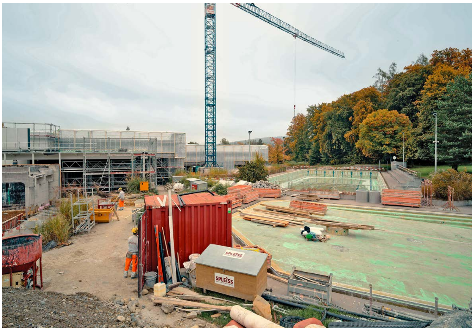
Blick auf die Grossbaustelle. Alle Baustellenaufnahmen stammen vom Oktober 2025.
