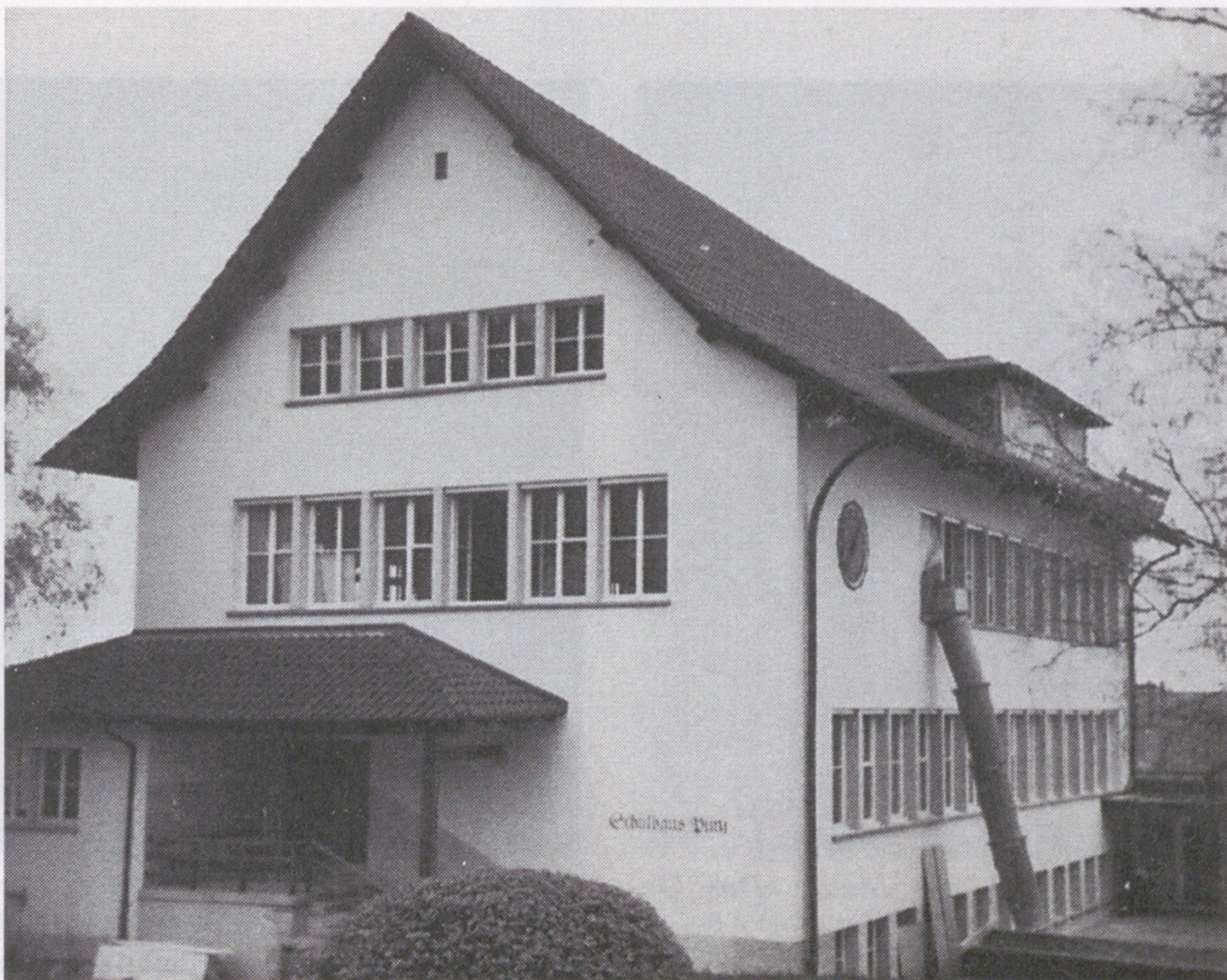
Die erste Etappe des Umbaus vom Schulhaus Pünt wird im Sommer beendet. (sl)
