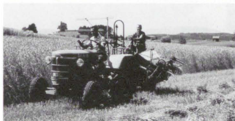
In den 50er und 60er Jahren erleichtert der traktor-gezogene Bindemäher die Getreideernte.
