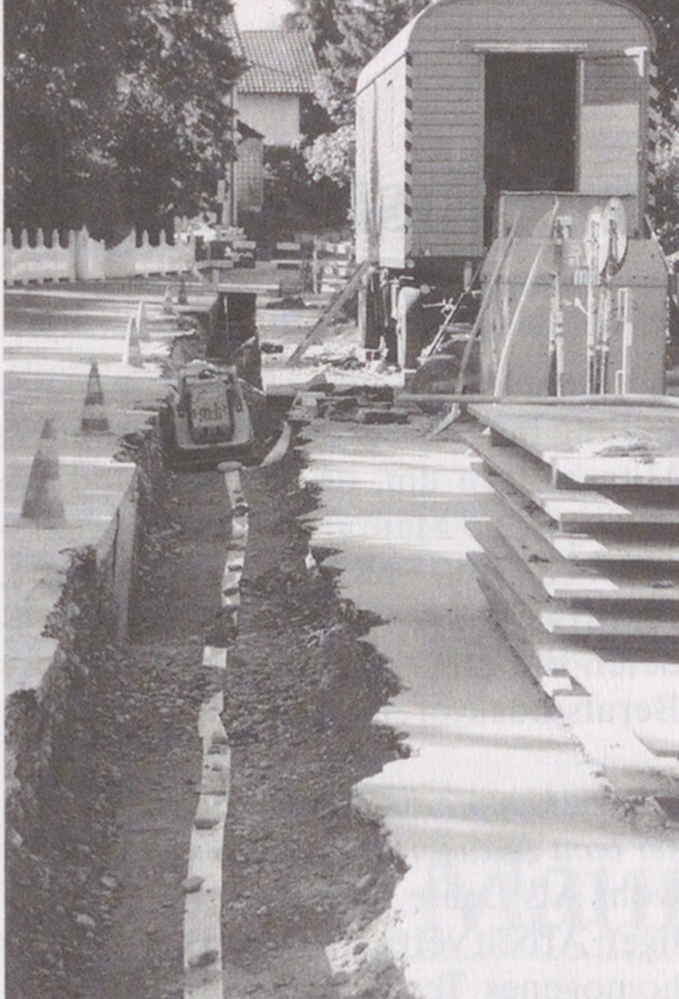
Voraussichtlich bis Ende Oktober wird die Tägernstrasse wegen Sanierungsarbeiten geschlossen bleiben. (Fotos: go)
