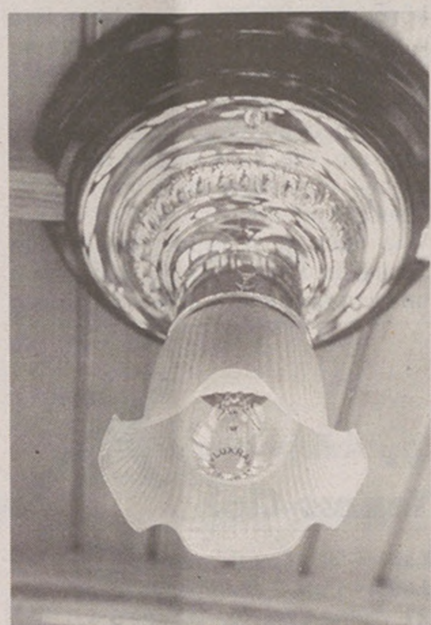
Aufwendige Rekonstruktion der Deckenlampen. Die Fassungen wurden in Berlin gegossen, das Lampenglas konnte in der Tschechoslowakei gefunden werden.
