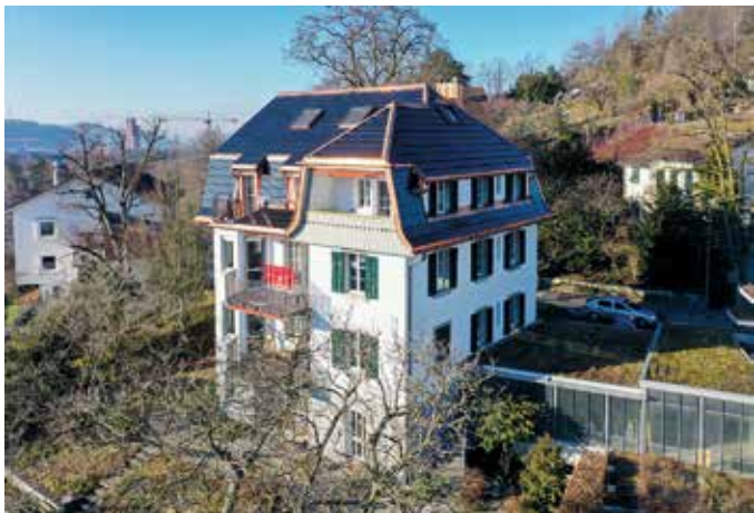
Dach oder Photovoltaikanlage? Beides. Dieses Hauses an der Rychenbergstrasse wurde mit Solarstrom-Elementen statt mit Ziegelsteinen gedeckt. (Foto: vvg)
