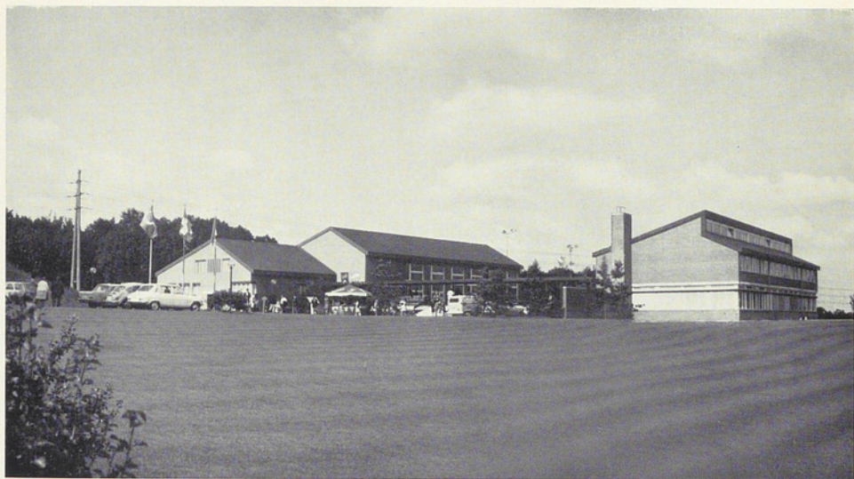
Die neue Schulanlage auf dem Chapf.
