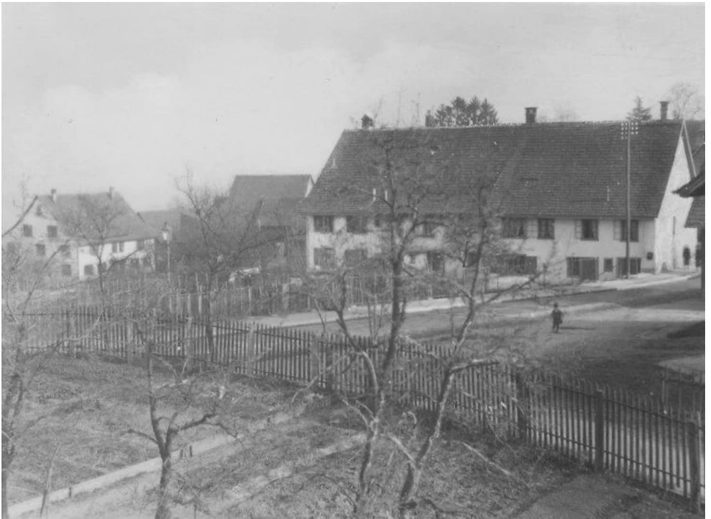
Obere Erdbrust. Hornerhaus, Widmerstr. 8, und Flarz Kilchbergstr. 97-101.
