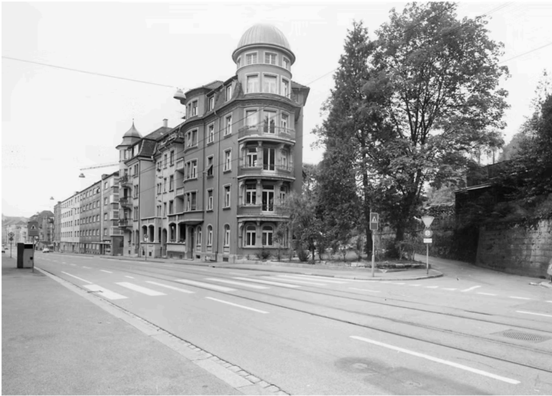
Vier mind. 5-stöckige Mehrfamilienhäuser Seestrasse 292-298. Architekt Alfred Iselin.
