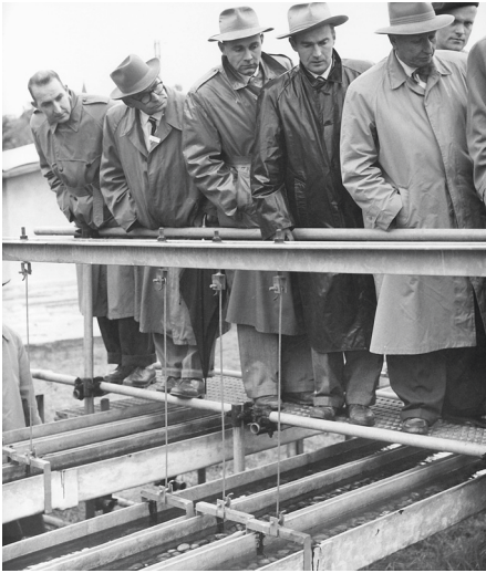
Experimentieranlage zur Selbstreinigung von Flüssen mit künstlichen Fliessrinnen in der Zürcher Tüffenwies um 1950.
