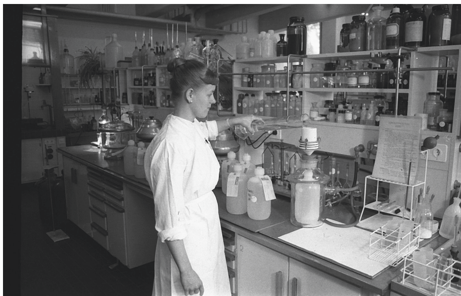
Blick in ein Eawag-Labor um 1955: Messung der Radioaktivität in Flusswasserproben.
