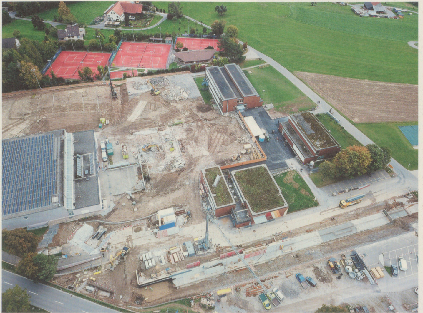
Loorenbaustelle Anfang Oktober: Die alte Turnhalle steht nicht mehr.
