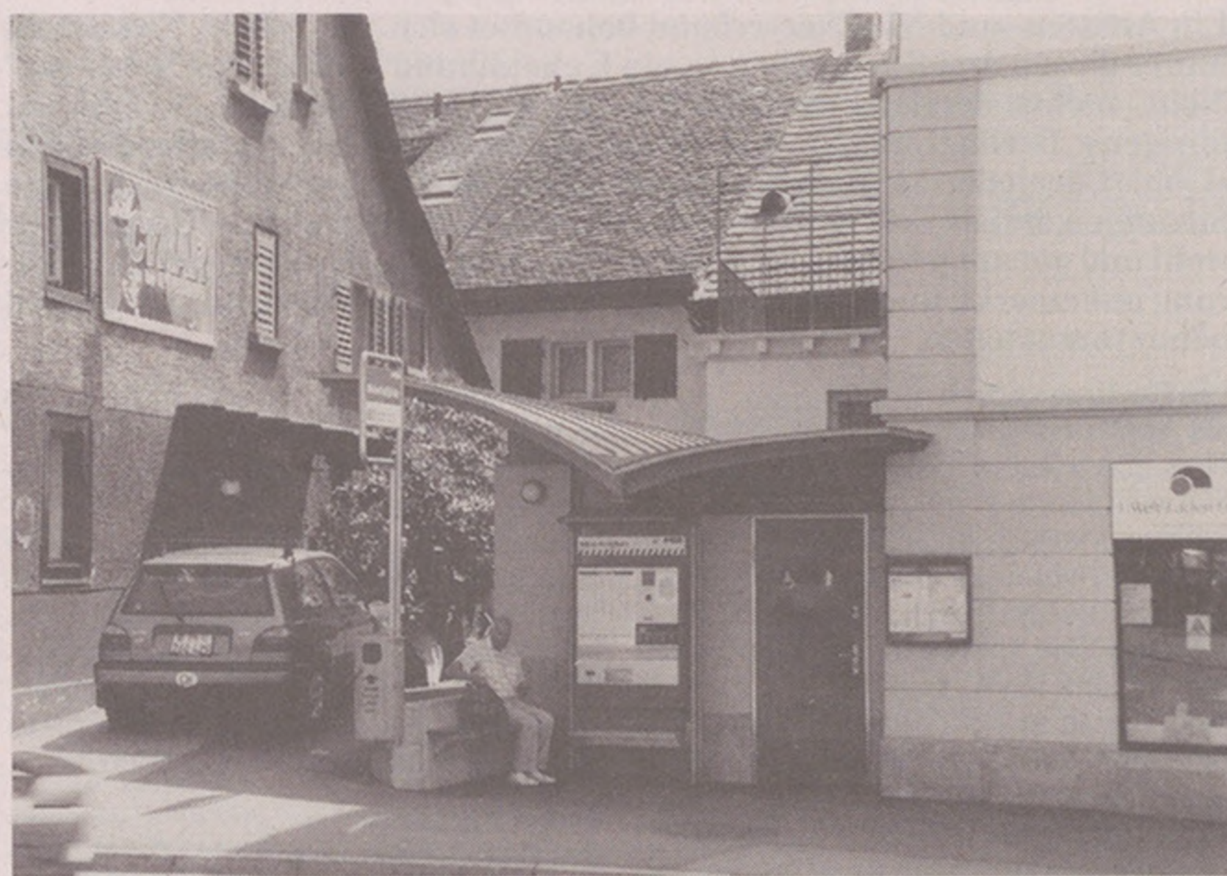
Die öffentliche, behindertengerechte WC-Anlage als neues Element, welches das langjährige Container-Provisorium am Meierhofplatz ersetzt. Das weitausragende, flügelartige Dach dient den wartenden Busbenutzern als Unterstand. Der Anbau, Fremdkörper, fand vorerst keinen Anklang bei der Bevölkerung. Ein Sturm der Entrüstung – Leserbrief-Flut im «Höngger» wie damals beim gelben Provisorium auf der Ostseite des Orsinihauses (siehe Bild vor dem Umbau) – wurde jedoch nicht ausgelöst.
