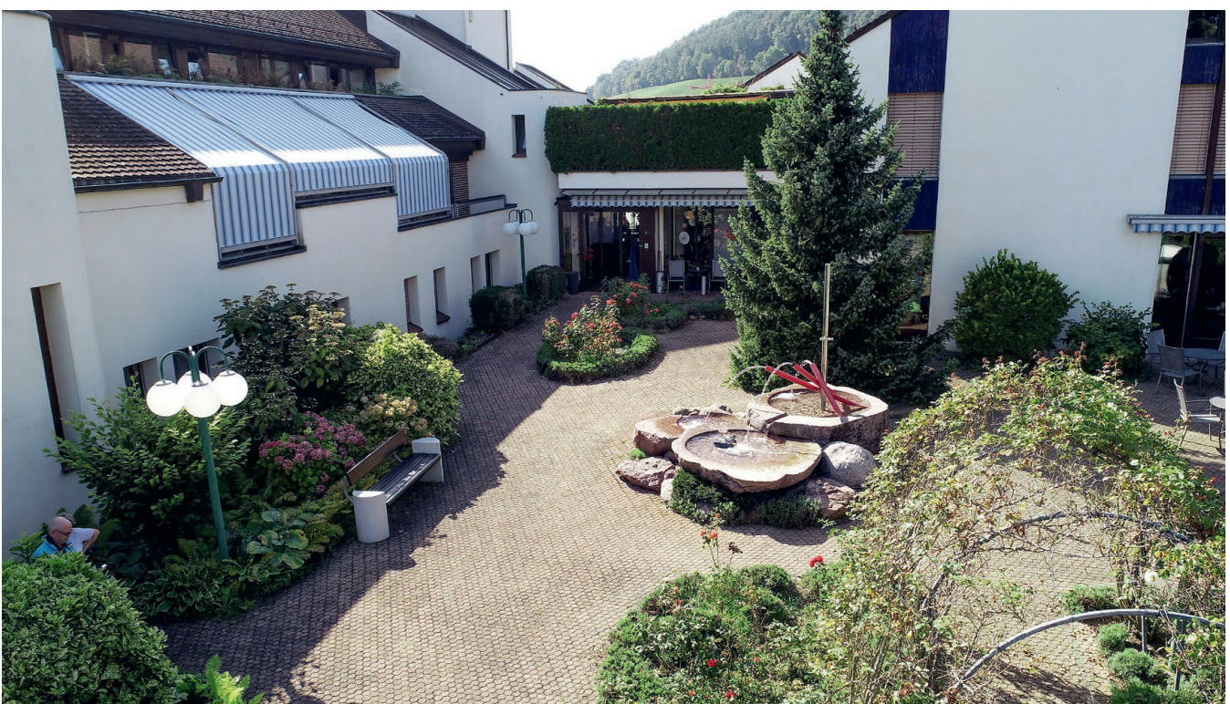
Eingangsbereich der bestehenden Anlage
