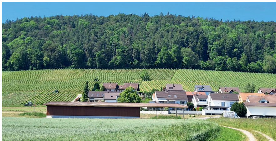
Standort der ersten grossen Photovoltaik-Anlage: Remise von Köbi Haug. Bild © Martin Rupf
