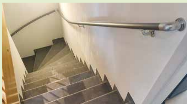
Wandseitiger Handlauf, dort wo die Stufen breiter sind.
