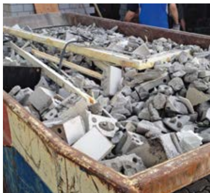
Der Abriss hinterlässt seine Spuren
