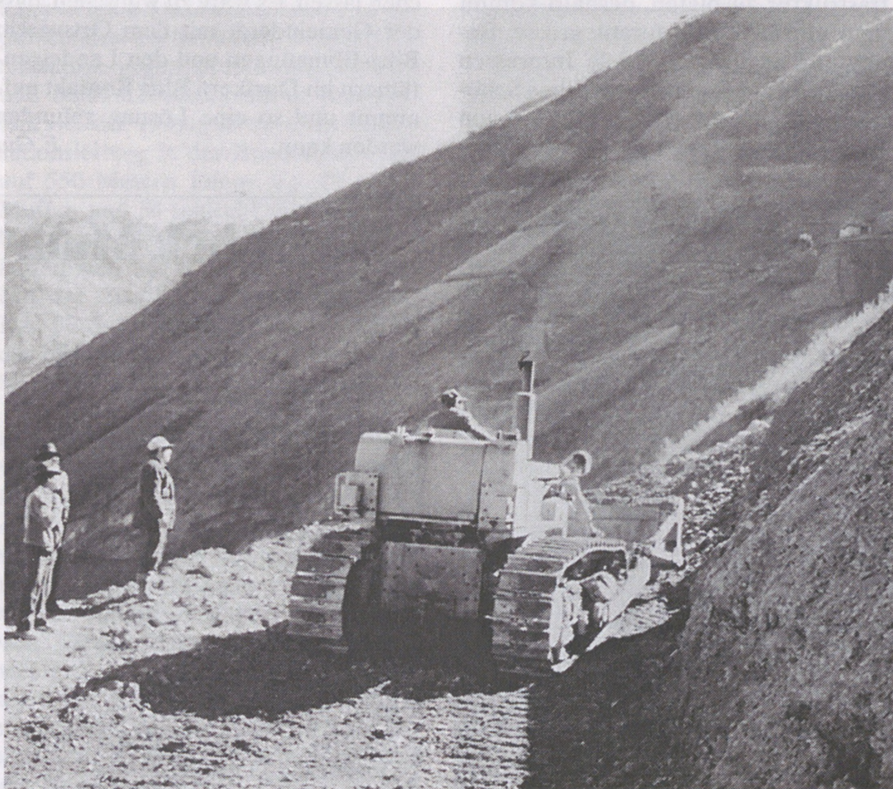
Die Arbeiten an den ersten Kilometern der «Carretera Suiza» der Erdrutsche wegen nicht ungefährlich. (Fotos: zvg)
