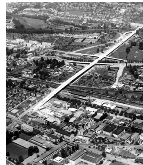
1963: Die Europabrücke wird dem Verkehr übergeben (Bild: BAZ_059043, Swissair)
