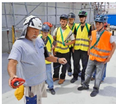
Vom Plan auf den Baustellenboden mit der Schlagschnur.
