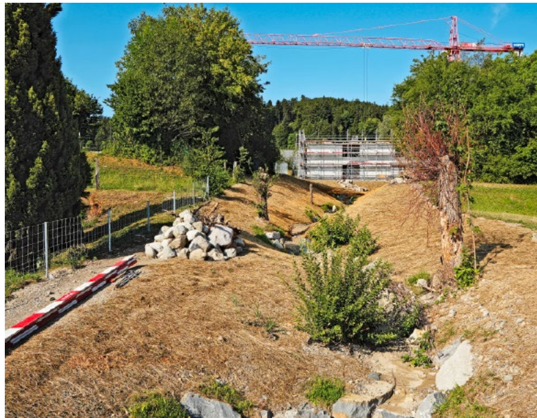
Rausenbach mit Steinstruktur/Eidechsenburg (links) und Blick zum eingerüsteten Bevölkerungsschutzgebäude.
