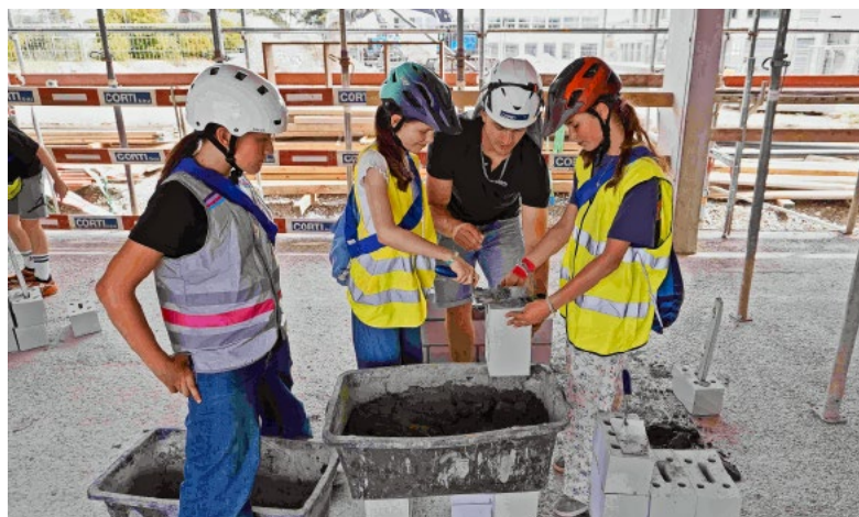
Grundzutaten für eine Mauer: Kelle, Mörtel und Stein.
