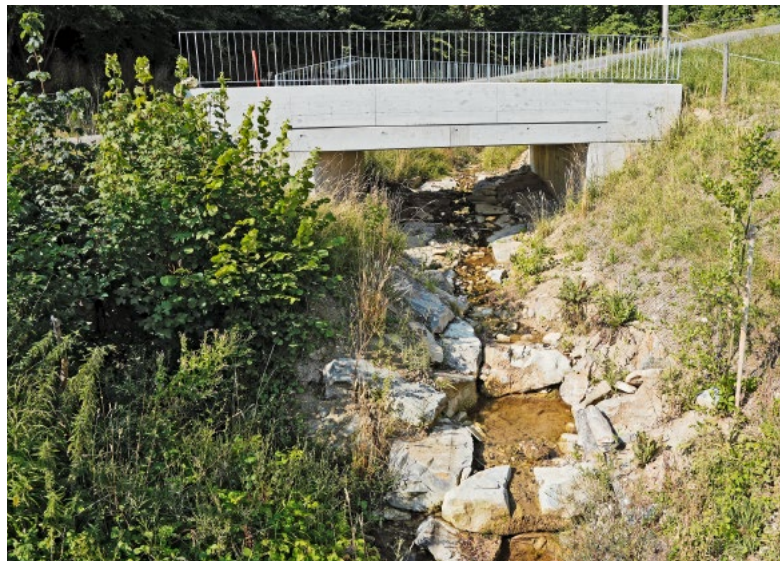
Uessiker Schulhausbach vis-à-vis vom alten Schulhaus in Uessikon mit der neuen Brücke.
