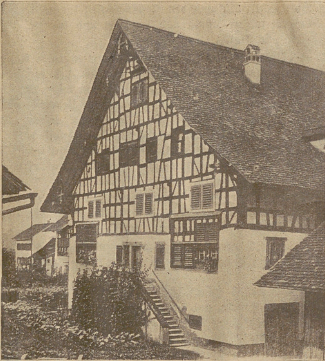
Altes Riegelhaus in Litzensee-Gombrechtikon.
