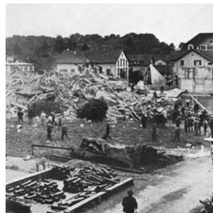
Bildersequenz der Kirchensprengung in Uster am 23. August 1963. Der Luzerner Architekt Wilhelm Keller (1823–1888) hatte das neugotische Gotteshaus 80 Jahre zuvor gebaut.
