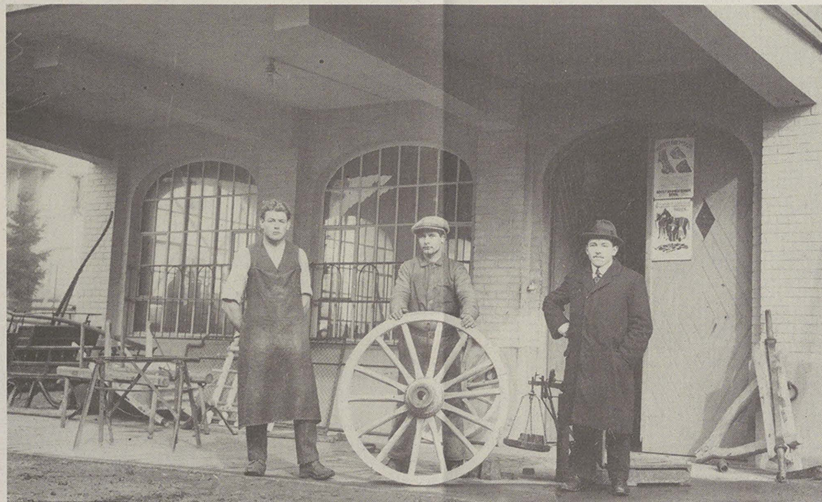
Beschlagbrücke der neuen Schmiede von 1924; Schmiedmeister Albert Meier (rechts in Mantel und Hut) muss weg und lässt seinen Betrieb unter der Obhut seines Bruders Alfred ; in der Mitte ein Schmiedegesse; Aufnahme zirka 1930/32 (Bild aus Familienbesitz).
