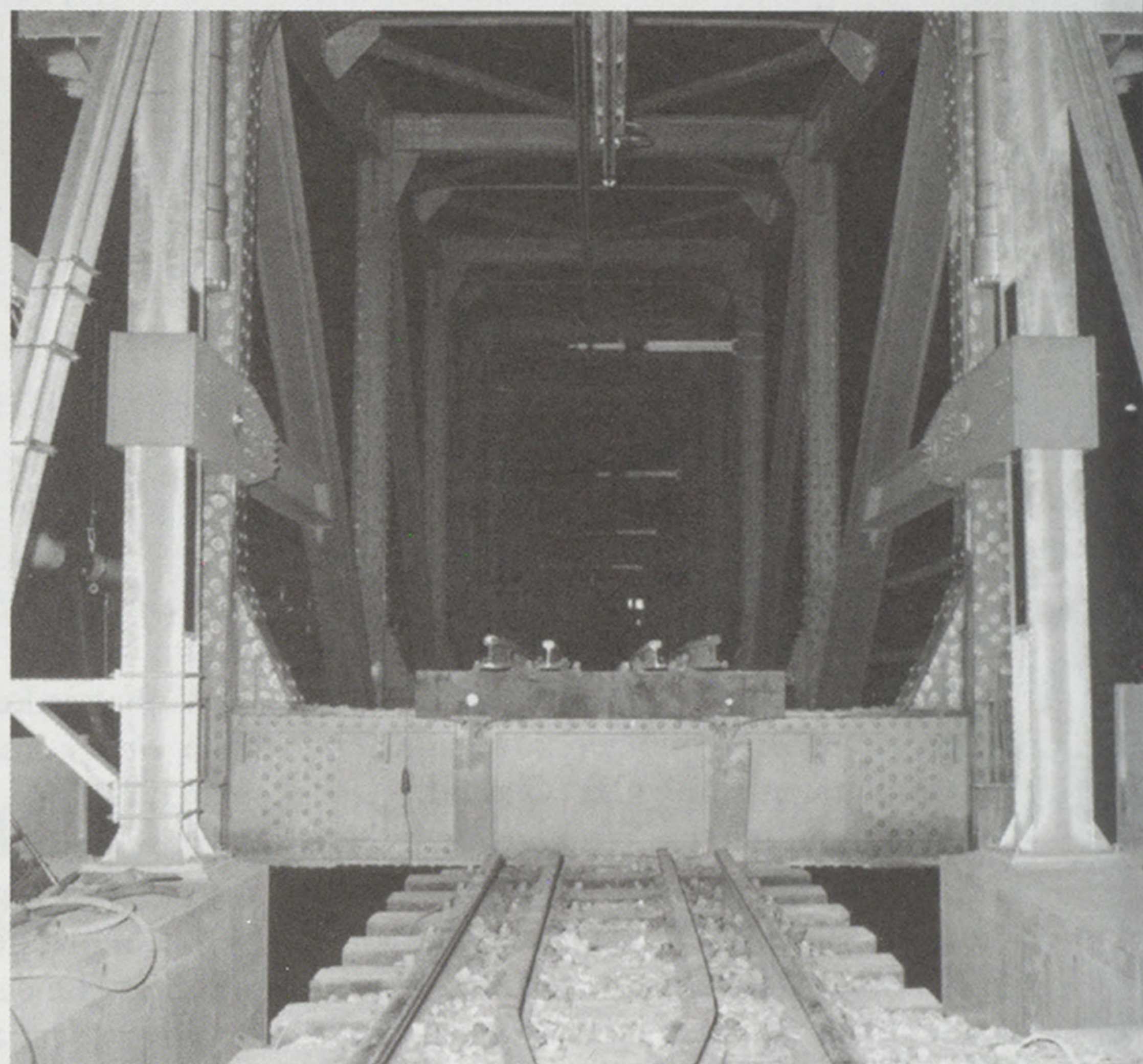
1,3 Meter kann die Brücke bei Bedarf mittels Steuerung angehoben werden. (Foto: zvg)
