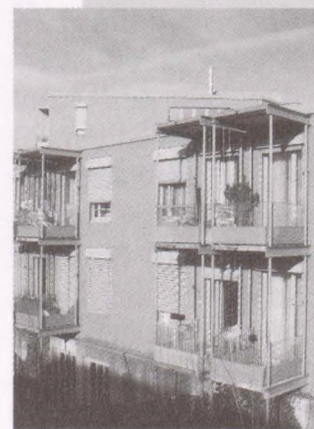
Ein Stockwerk mehr für grössere Alterswohnungen.
