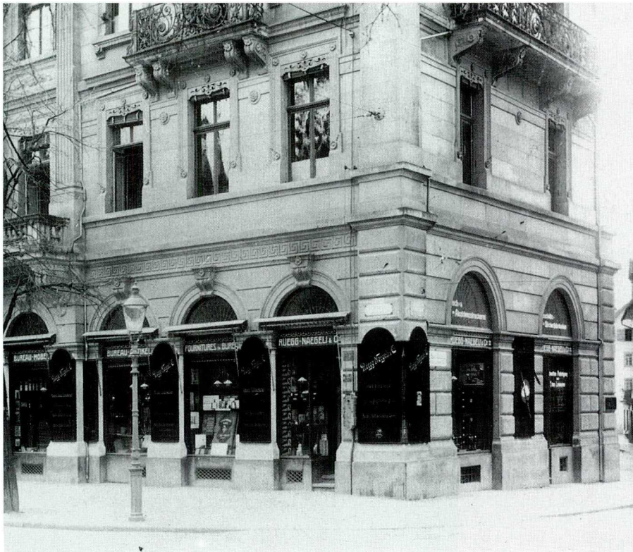
Abb. 83. Bahnhofstrasse 27 / Ecke Bäregasse (vor der Jahrhundertwende)
