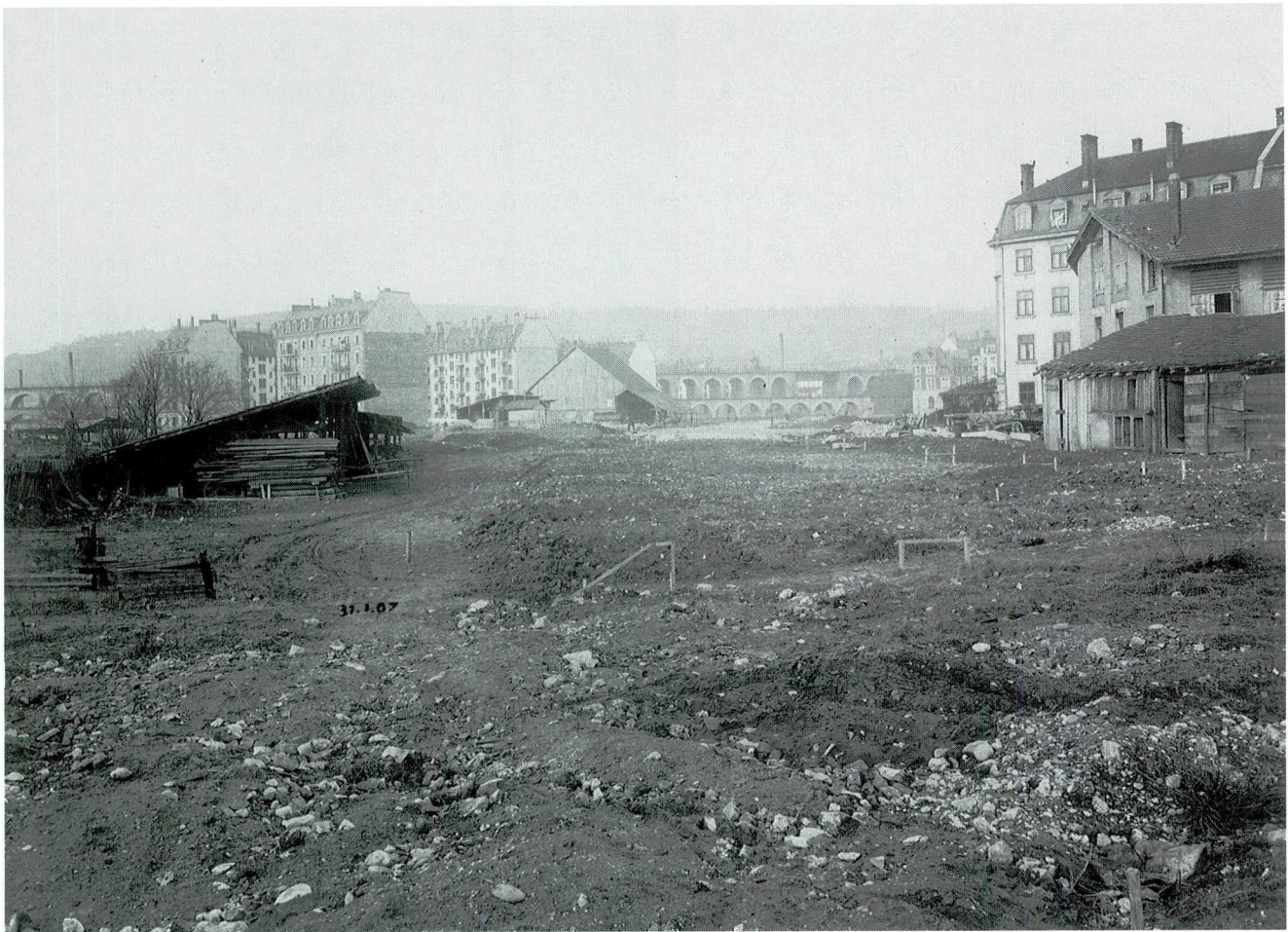
Abb. 14. Röntgenstrasse im Bau (1907)
