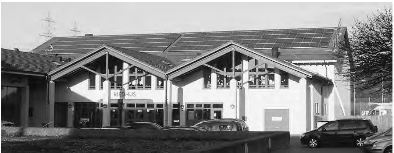
Ansicht Anlage 3 Riedhus
