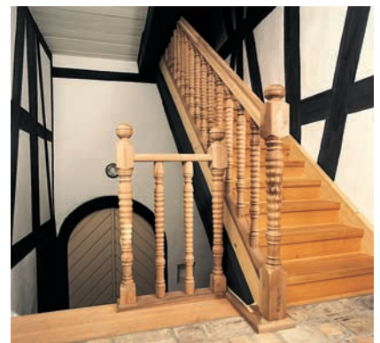
Treppenhaus mit Tonplattenboden.
