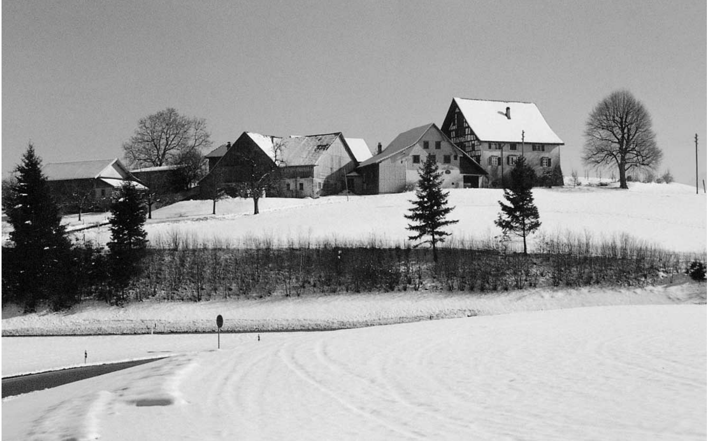
Gehöft Luggenbüel mit Wohnhaus von 1692 und Ökonomiebauten. Ansicht von Norden, 1999.
