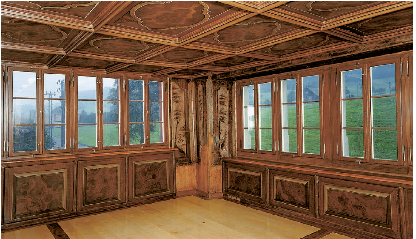
In der Stube in der Südecke des ersten Obergeschosses wurde 1987/88 figürlich ausgemaltes Wand- und Deckentäfer freigelegt und erhalten.
