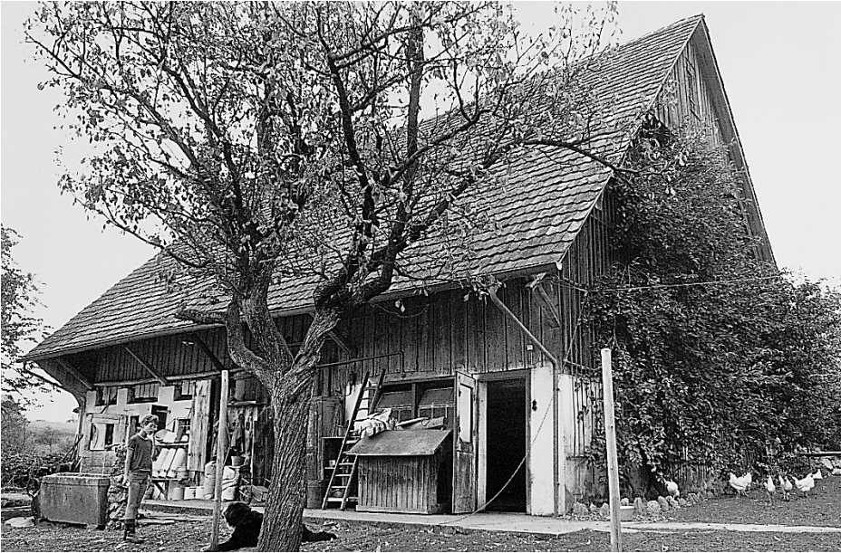
Nordostansicht der Stallscheune Vers.-Nr. 1538.
