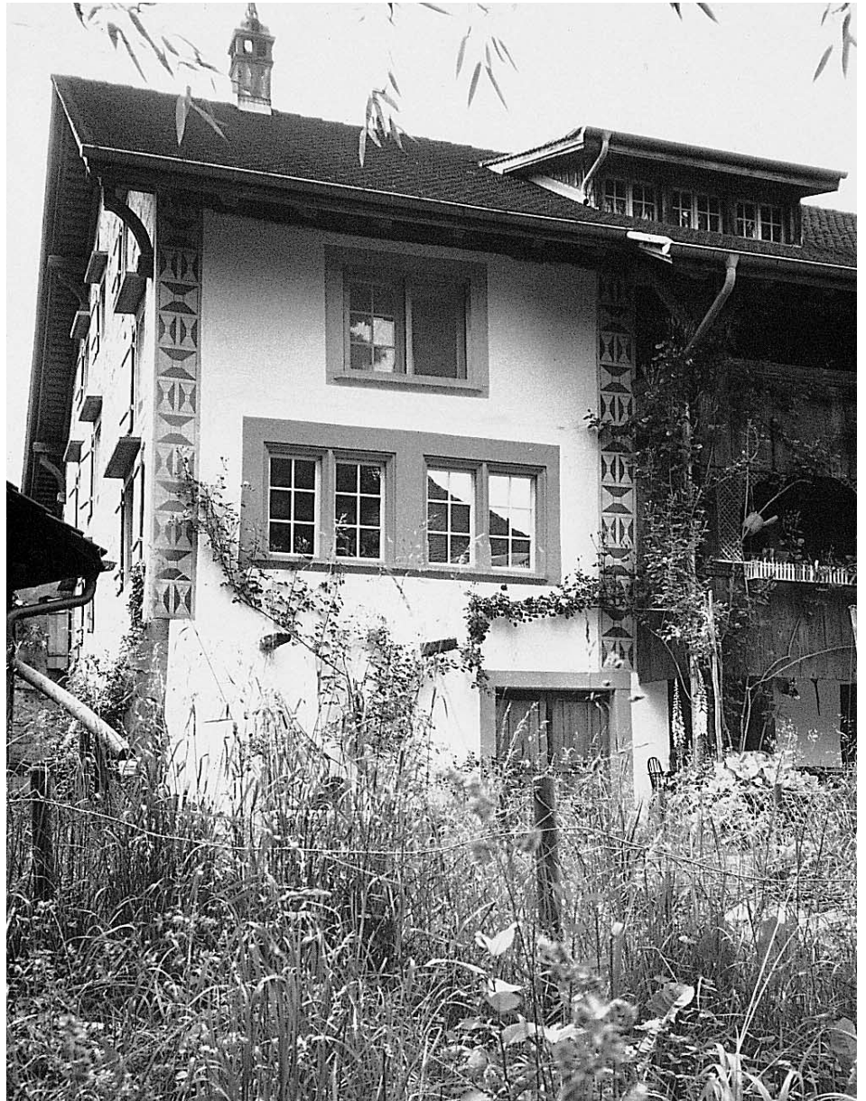
Rückseitiger Anbau mit Heimatstilverputz von 1926, nach der Renovation von 1984/85.
