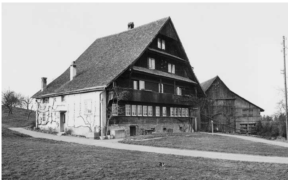
Bauernhaus Unter Ödischwänd, Vers.-Nrn. 1392/1393. Ansicht von Süden, 1976.
