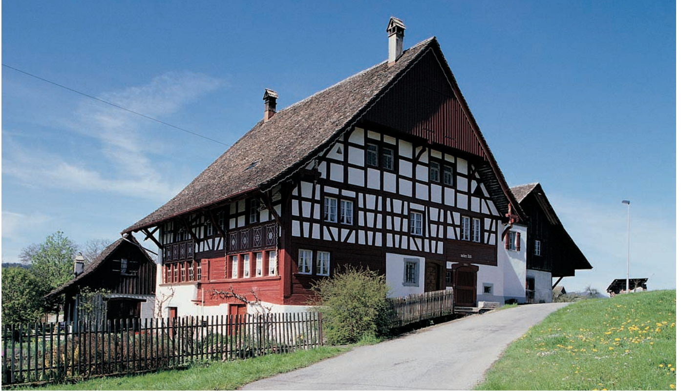
Bauernhaus Vordere Rüti von 1654. Nördliche Giebelseite mit Bohlen- und Riegelwerk, nach der Restaurierung von 1995.
