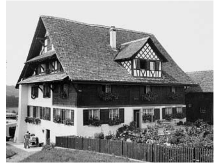
Südliche Giebelfassade: Verputz, Bohlen- und Fachwerkwandteile. Fachwerk mit Klebdächern im Giebelfeld.
