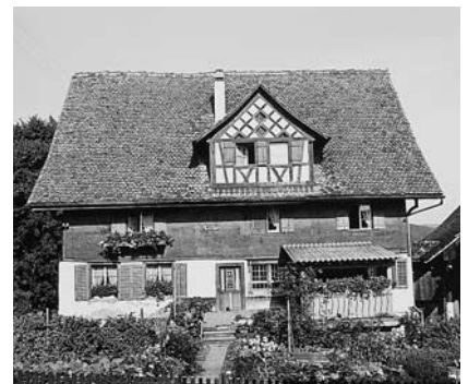
Östliche Traufseite mit Bohlenwand im Obergeschoss.
