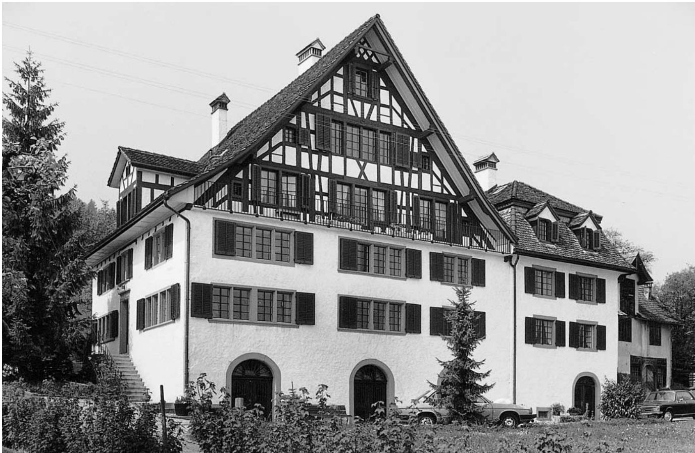
Haus Rötiboden Vers.-Nr. 880. Seeseitige Fassade mit 1974/75 freigelegtem Fachwerk im Giebel.
