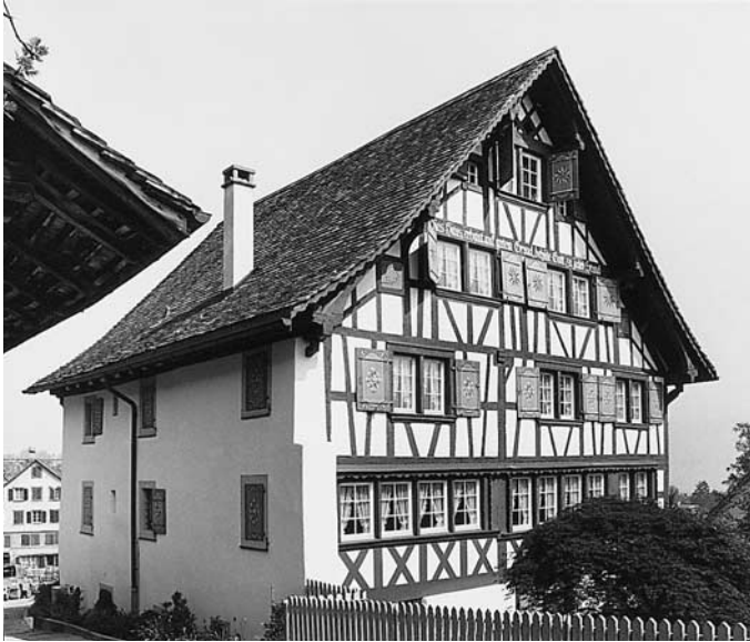
Oben links: Südwestansicht mit gemauerter Trauffassade zur Leigass. Oben rechts: Nordfassade mit Hauseingang.
