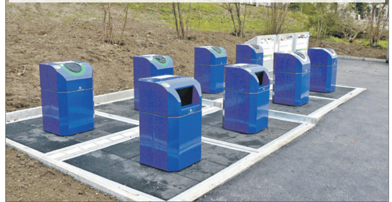
Aufgeräumt und offener: Die neue Unterflur-Wertstoff-Sammelstelle an der Ecke Riedhofstrasse/Wieslergasse. (Foto: Fredy Haffner)
