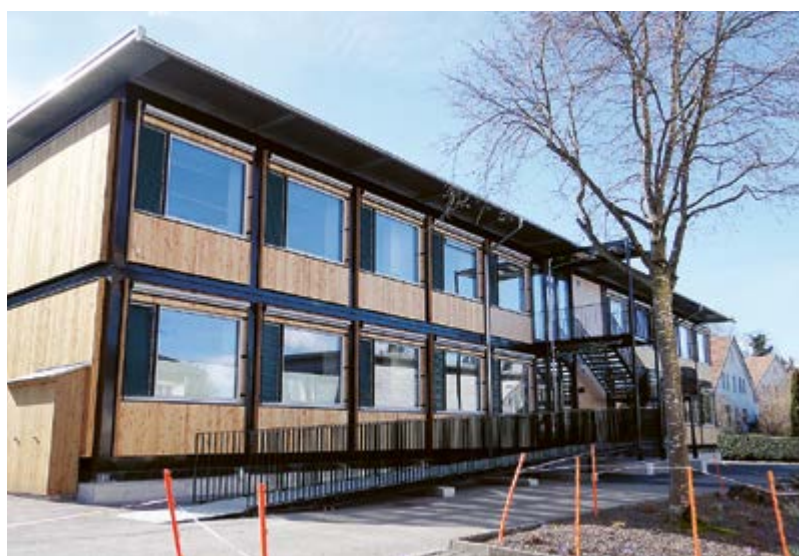
Der Pavillon – zusätzlicher Schulraum bei der Schule Pünt Bild: Stephanie Kamm
