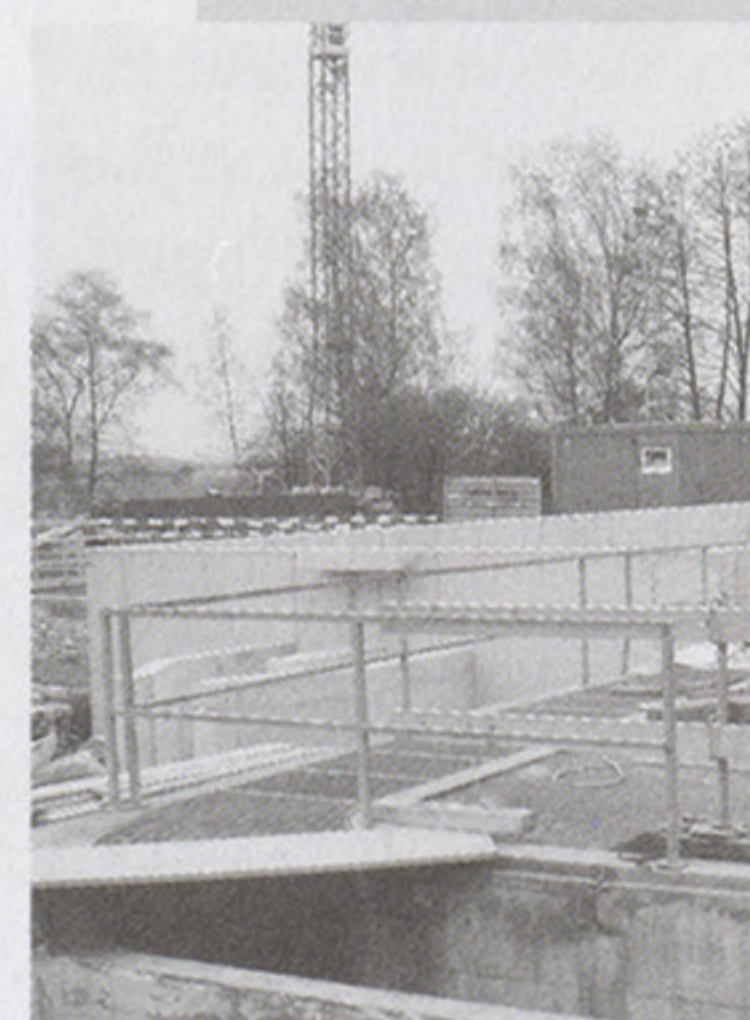
Die Filteranlage, eines der wichtigsten Elemente ist fertig. Trotzdem wird das Gelände der ARA noch bis 2006 eine Baustelle sein.
