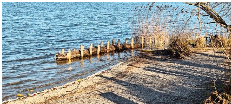
3. April 2025 – dieselbe Lahnung nach der Befüllung.
