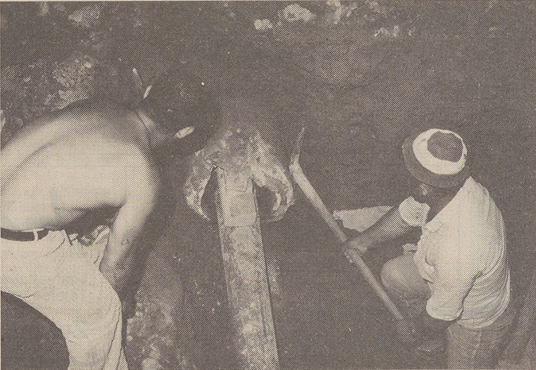
Erneuerung eines Abwasserkanals
