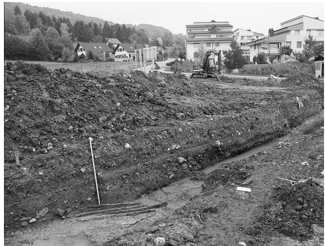
Abb. 10. Mettmenstetten. Grundrebenstrasse. Blick auf die angerissene Prügellage (links im Vordergrund).
