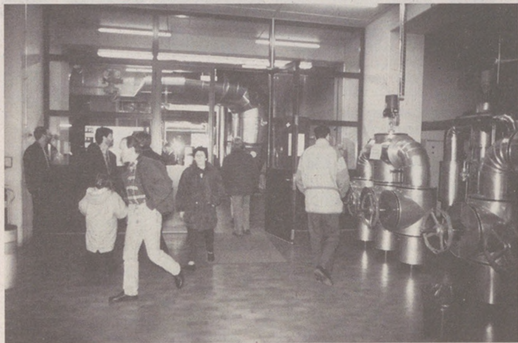
Rund 600 Besucher kamen am Tag der offenen Tür in die neu sanierte Heizzentrale der ETH Hönggerberg. (Foto: R. Sahli)
