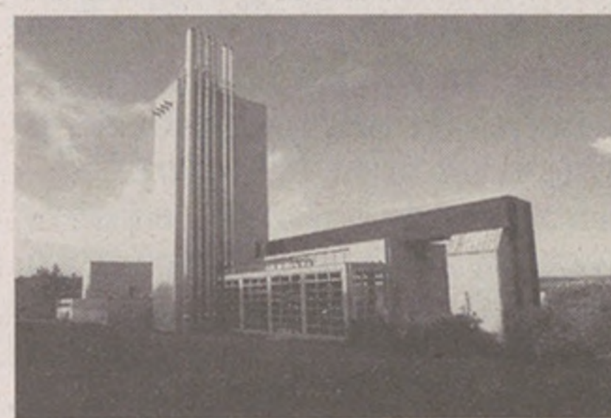
Trotz notwendiger Eingriffe in die bestehenden Bauten gelang es, die architektonische Qualität der Zentrale weitgehend zu bewahren. (Foto: R. Brendel)
