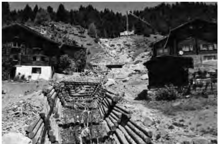
Prov. Sanierung mit Randhölzern 2003
