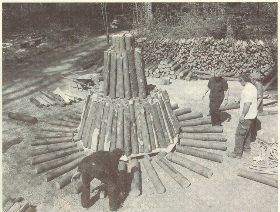
Der Kamin ist gesetzt und befestigt
