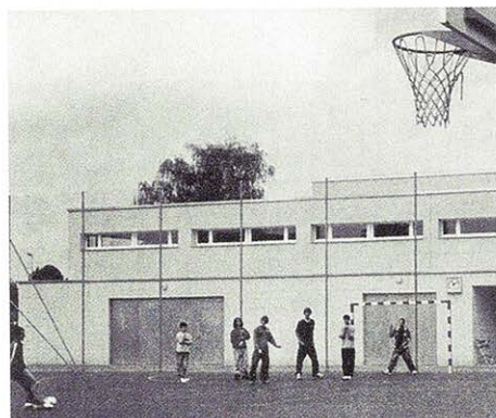
Oberstufenschulhaus Bruggwiesen, Bruggwiesenstr. 4, Brüttisellen
