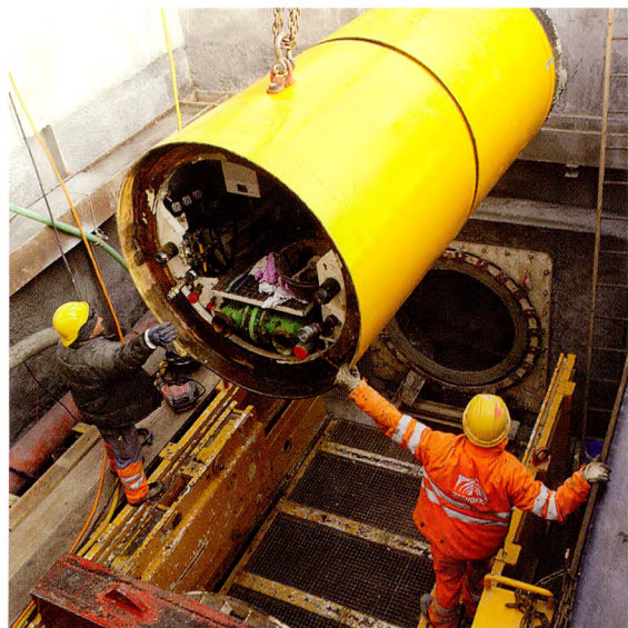
Der Bau des neuen Abwasserkanals gewährt interessante Einblicke in den Untergrund der Bahnhofstrasse.
