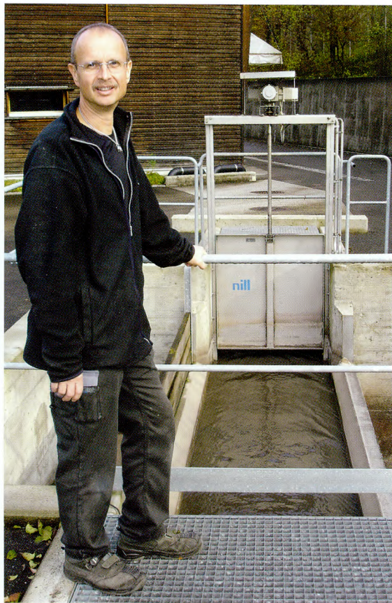
Klärwerkmeister Markus Gassmann beim Einlaufkanal. Hier fliessen alle Abwässer der Gemeinde in die Kläranlage.
