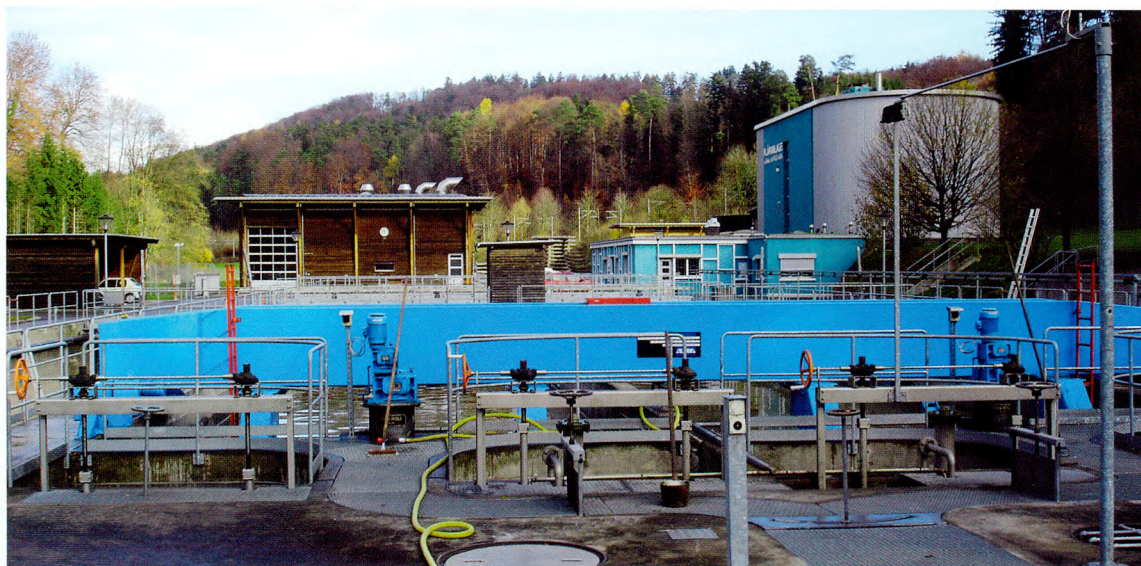
Die 1968 eröffnete und 1998 erneuerte Kläranlage Mannenberg befindet sich am tiefsten Punkt der Gemeinde (477 m).
