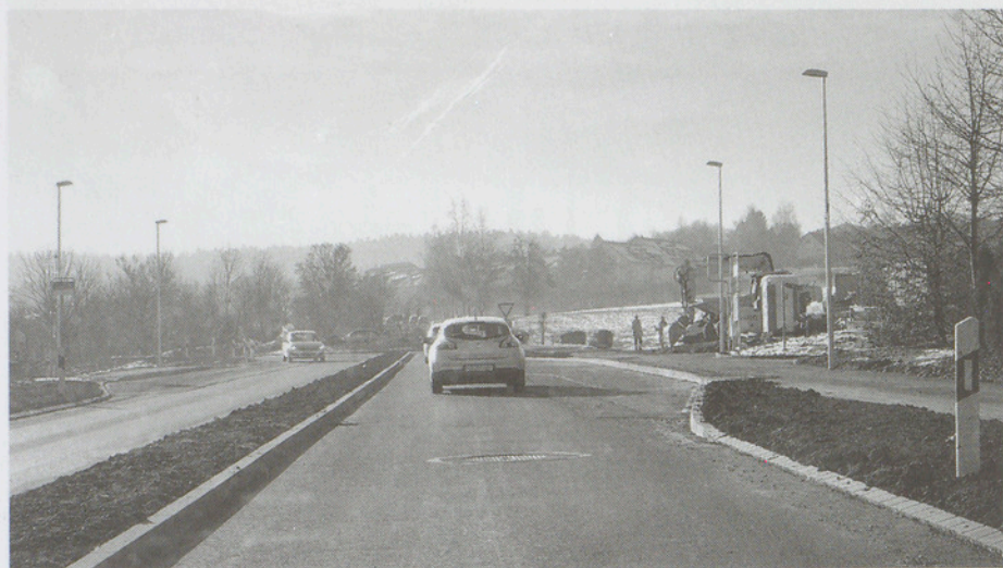
Die beiden Bushaltestellen-Buchten Langwis von der Fahrt von Fällanden Richtung Binz.
