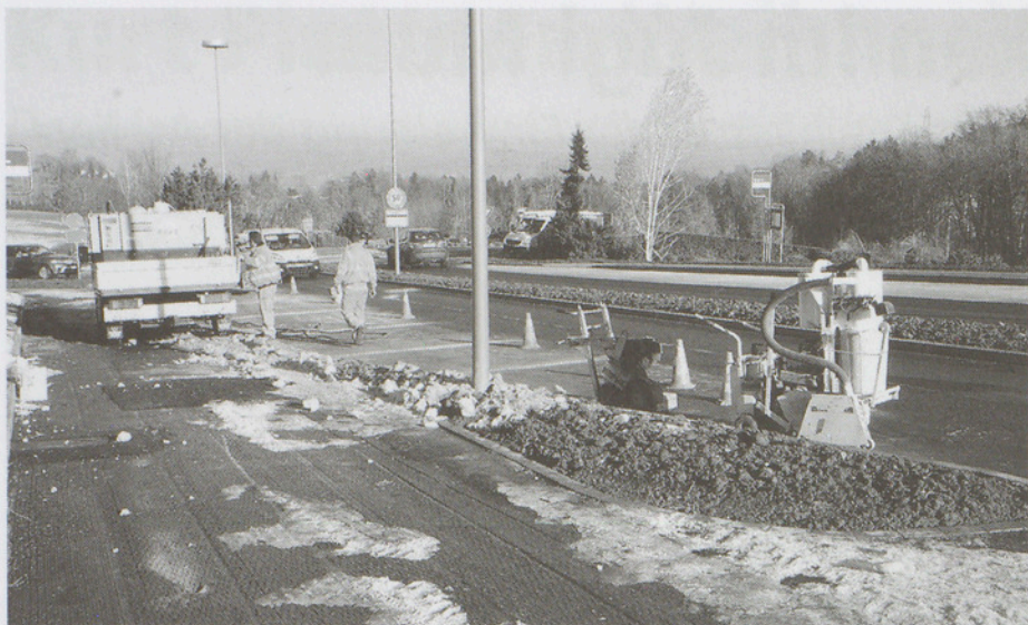
An der Haltestelle «Bautacher» werden die letzten Arbeiten vorgenommen.
