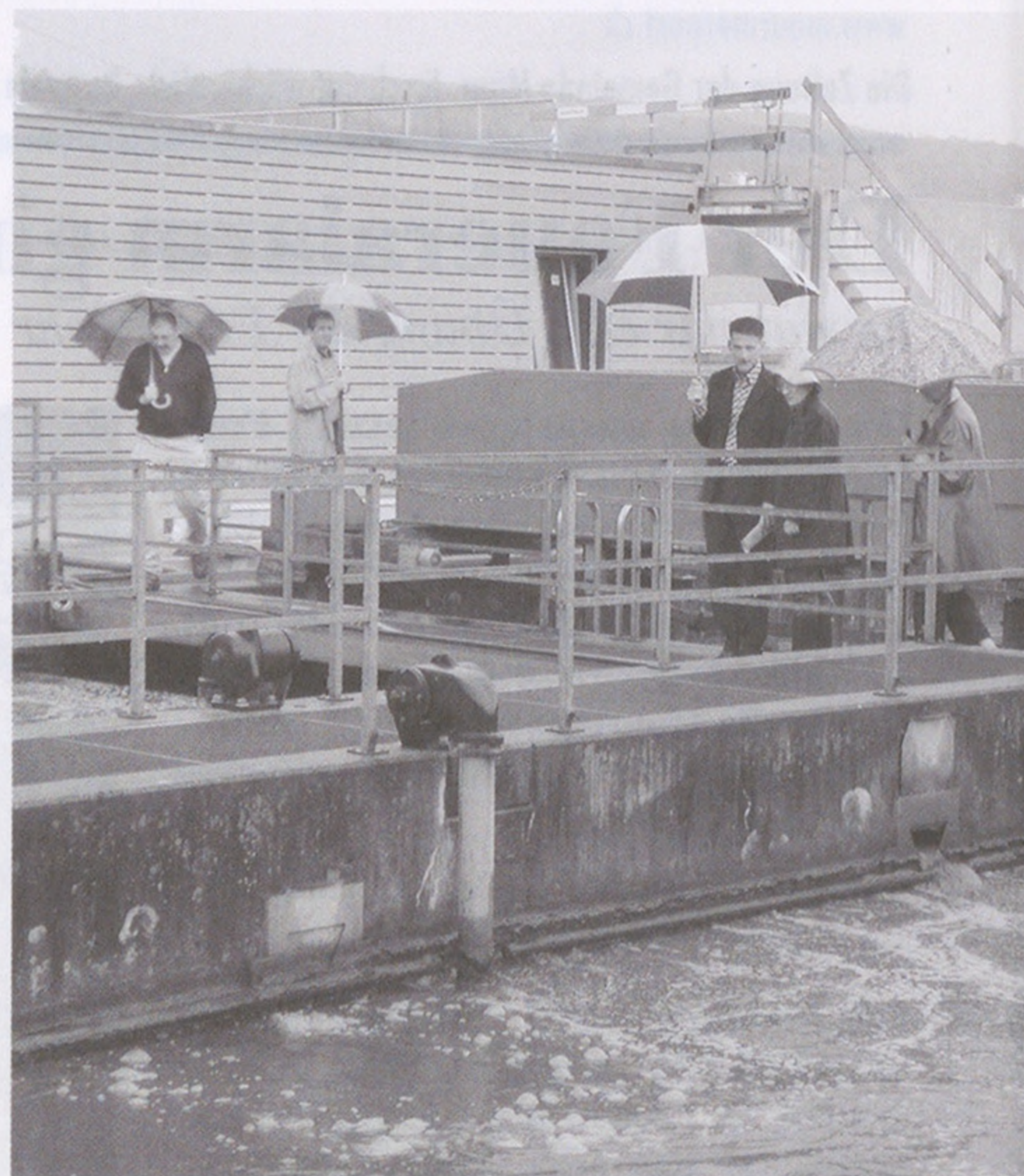
Baubegehung der ARA Fällanden. Im Hintergrund ist das mit grau gestrichenen Holzleisten verpackte Gebäude zu sehen, das die neue Filtrationsanlage beherbergt. (Foto: gw)
