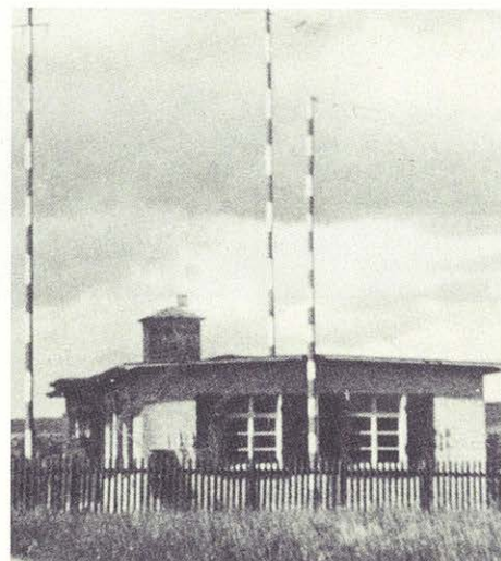
Noch heute ist das 1925 in den Wechselwiesen am Fussweg nach Brüttisellen erstellte Funkhaus zu sehen
