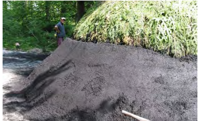
Ein Teil des Löschimantels ist bereits aufgebracht
