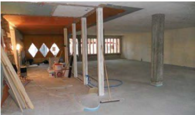
Noch ist die Bibliothek eine Baustelle
