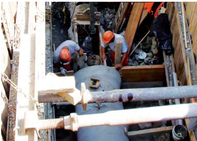
Arbeiten für den Kanalzusammenschluss an der Kanzleistrasse
