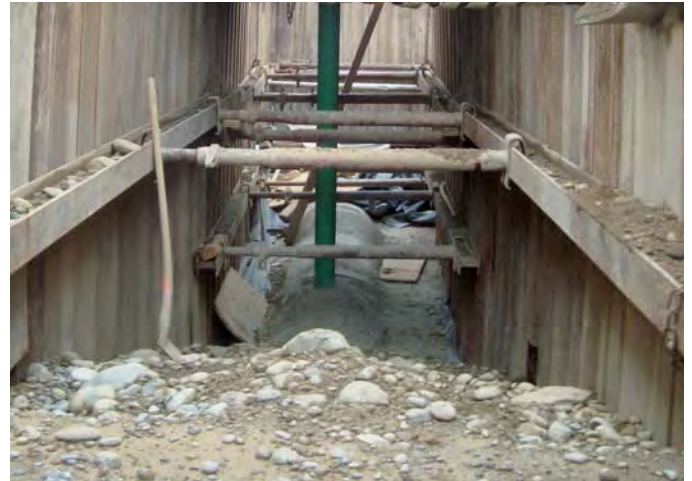
Ein Kanalgraben aus Arbeitersicht an der Kanzleistrasse
