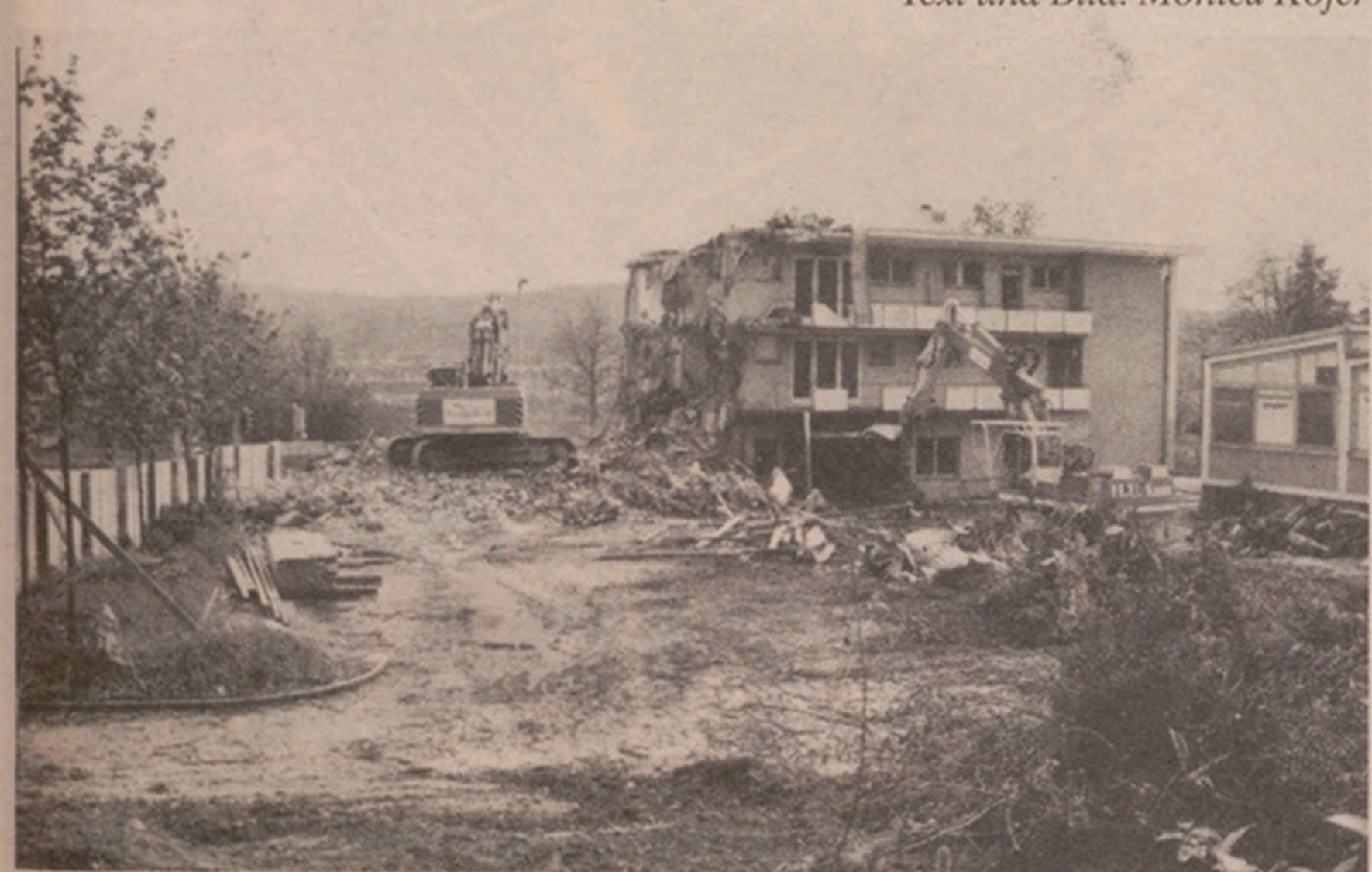
6. Mai 1991: Abbruch auf dem Areal Ryser bei der Tramendstation im Frankental.
